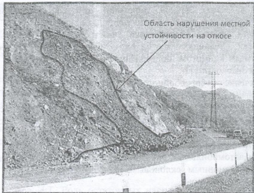
Рис. 1. Нарушение местной устойчивости откоса на автомобильной дороге
